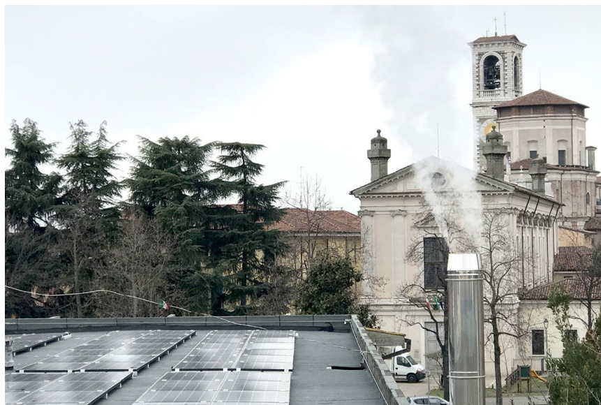
ZeroEmissioni: gli scarichi dismessi della vecchia centrale termica a GAS e la nuova centrale fotovoltaico
