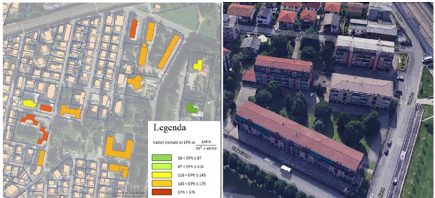
Stima di riqualificazione energetica e dei tempi di rientro degli investimenti su 4 edifici limitrofi
