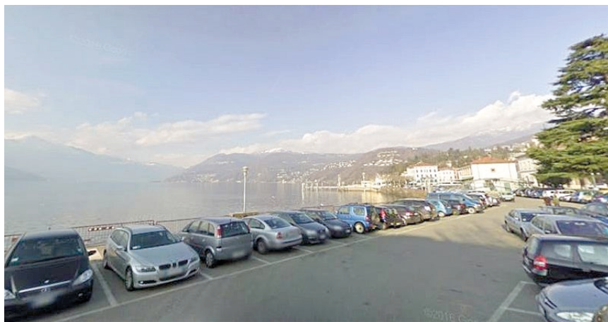
Progetto Lungolago: prima e dopo l'intervento
