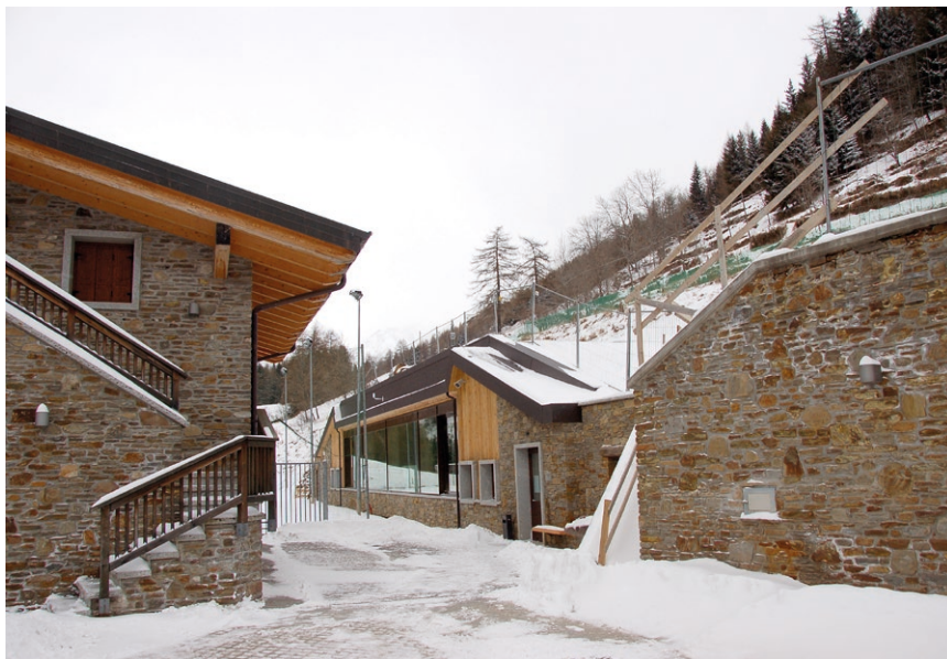
Bocciodromo presso il centro sportivo di Pezzo Comune di Ponte di Legno (BS)
