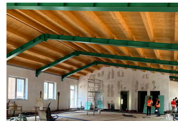
Fase di Cantiere
