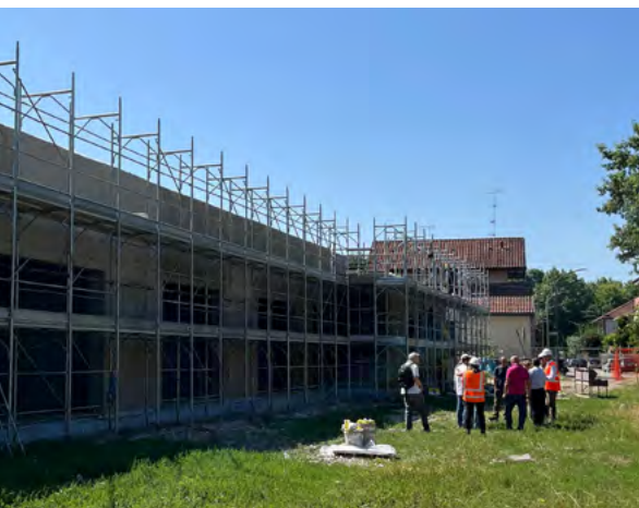
Fase di Cantiere
