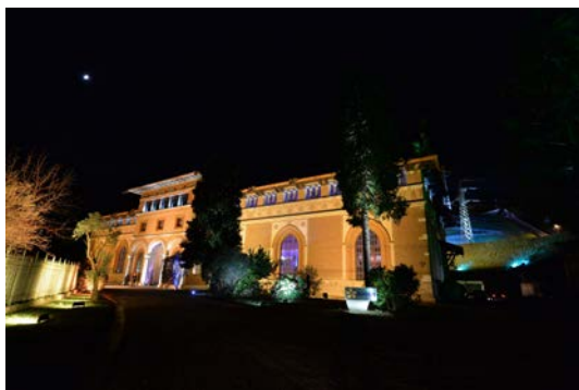
Centrale idroelettrica Esterle, riqualificazione illuminotecnica
